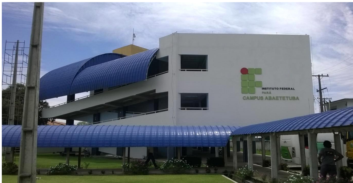
Figura 2 – Prédio Pedagógico do IFPA Campus Abaetetuba, com 12 salas de aulas.
